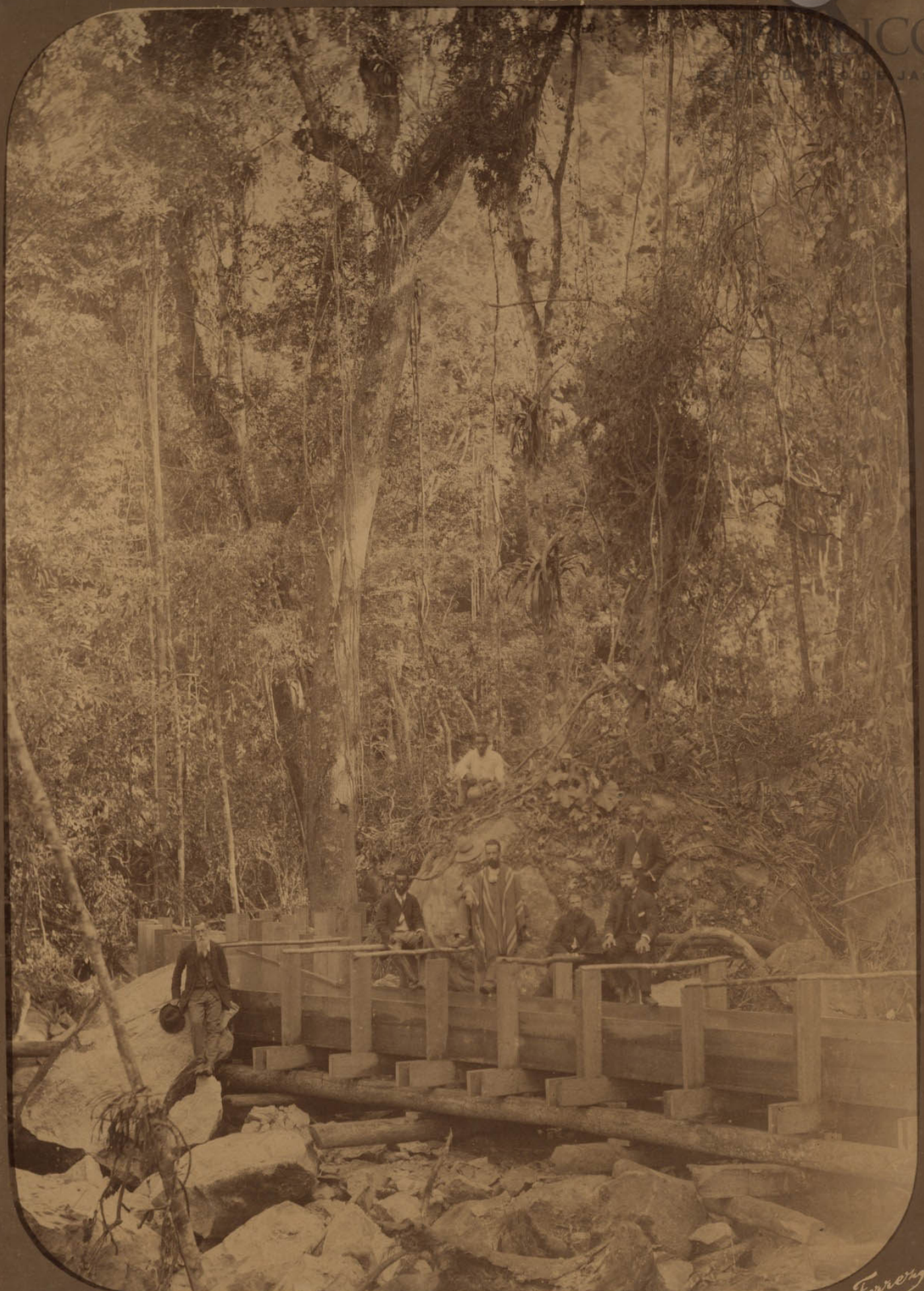
Aqueducto da Limeira
