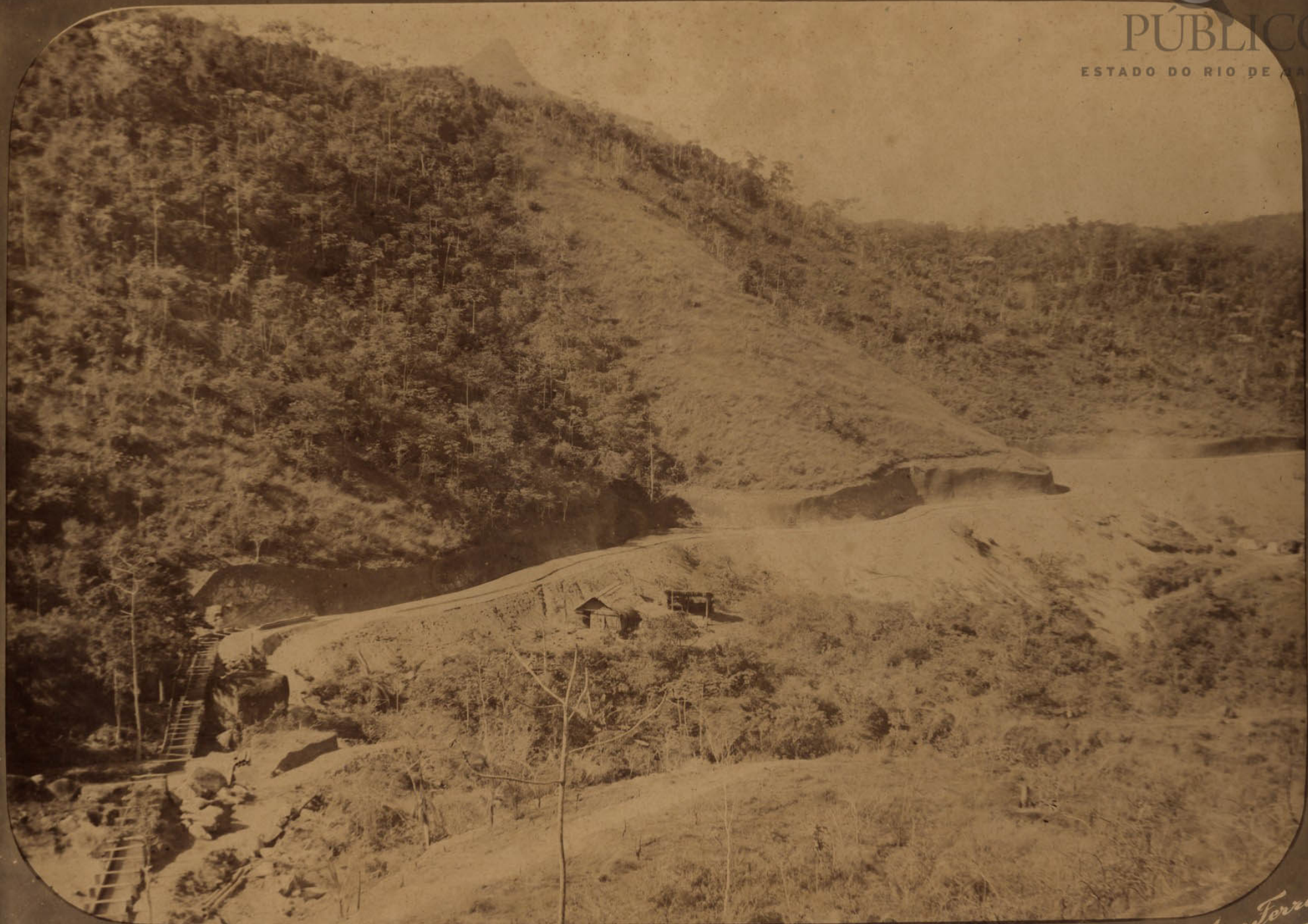
Trecho do aqueducto entre as cachoeiras da pedra lisa e Nery
