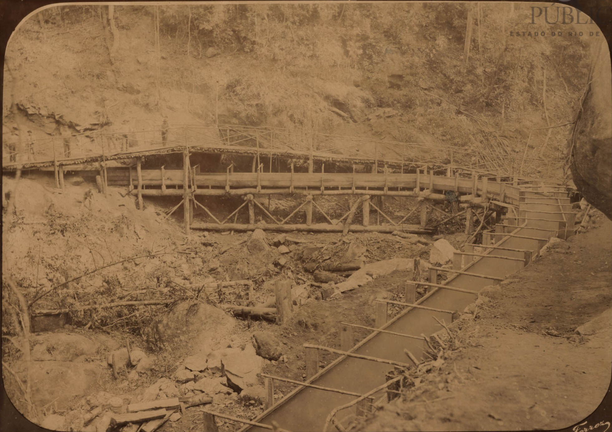
Aqueducto do Soldado .
