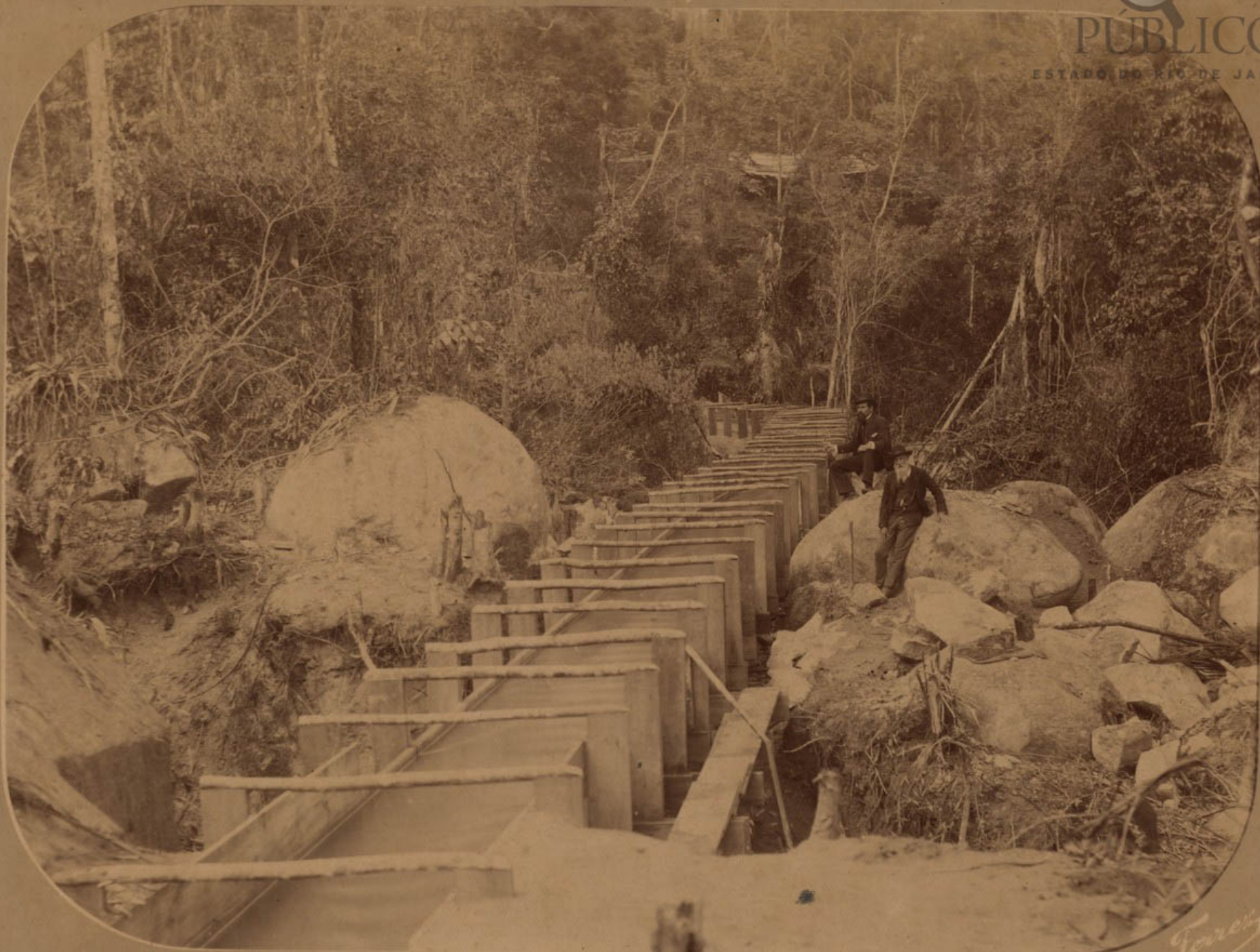
Aqueducto do Soldado
