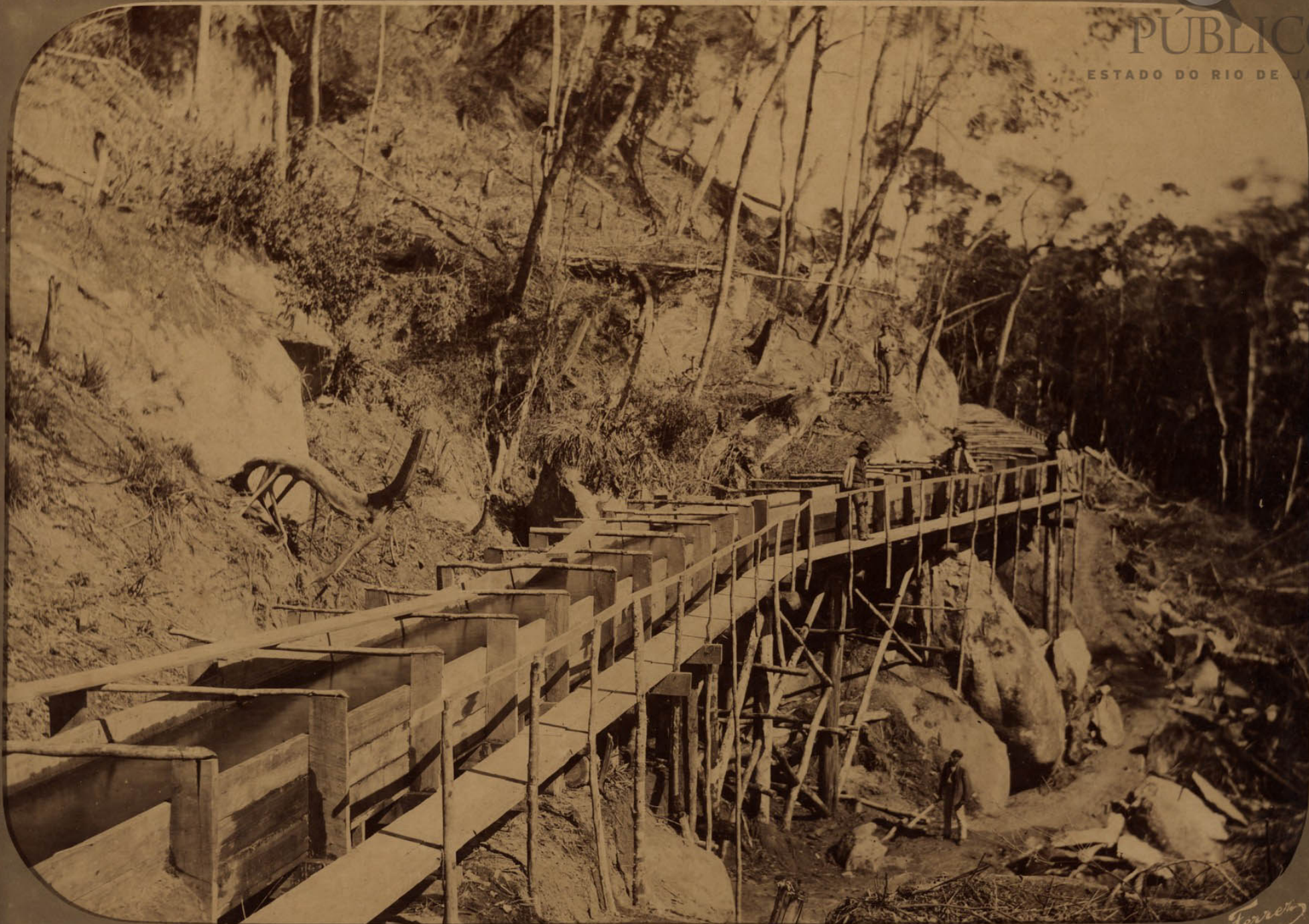
Aqueducto dos Rochedos K. 7.
