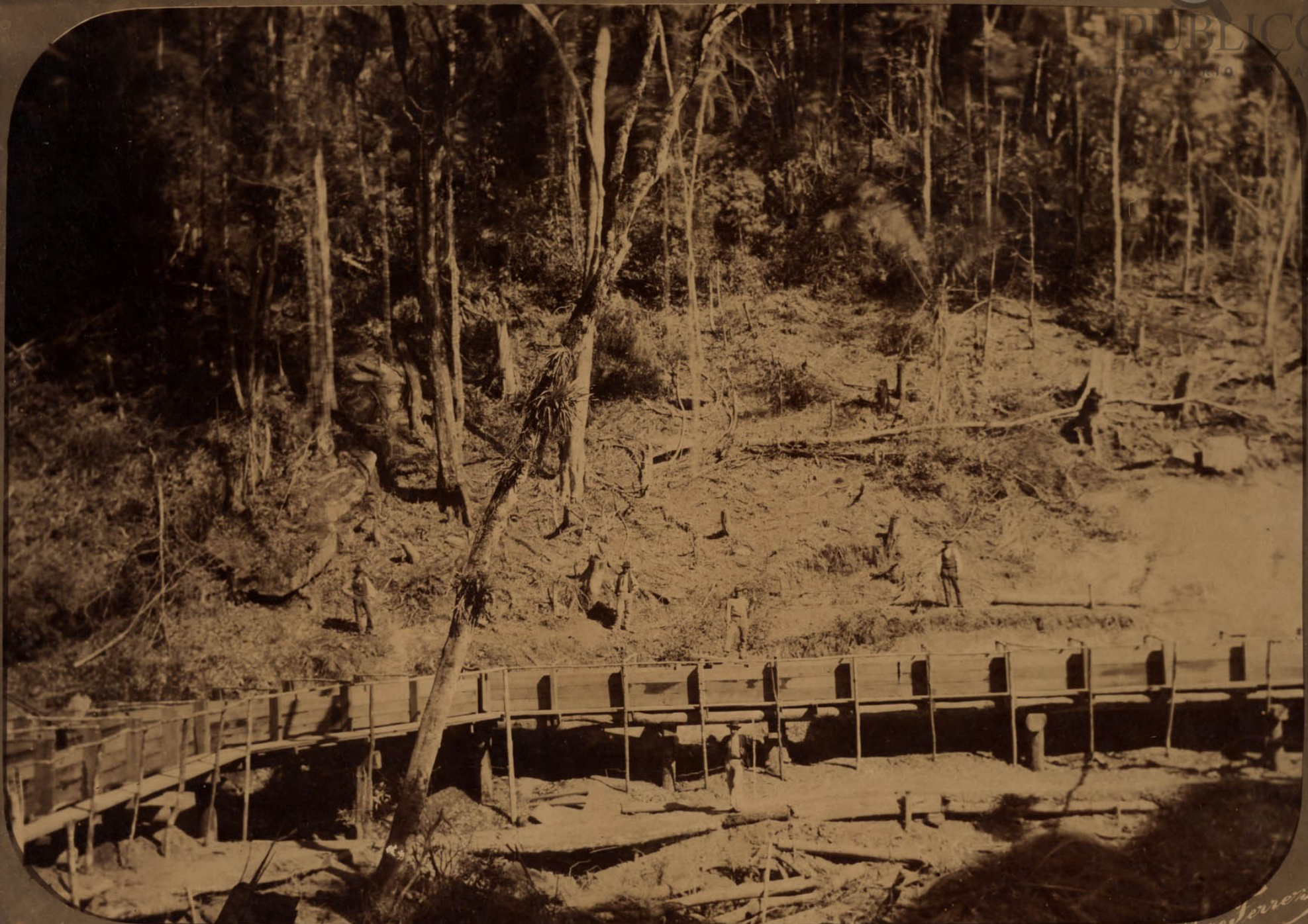
Aqueducto da Ferraria K.7
