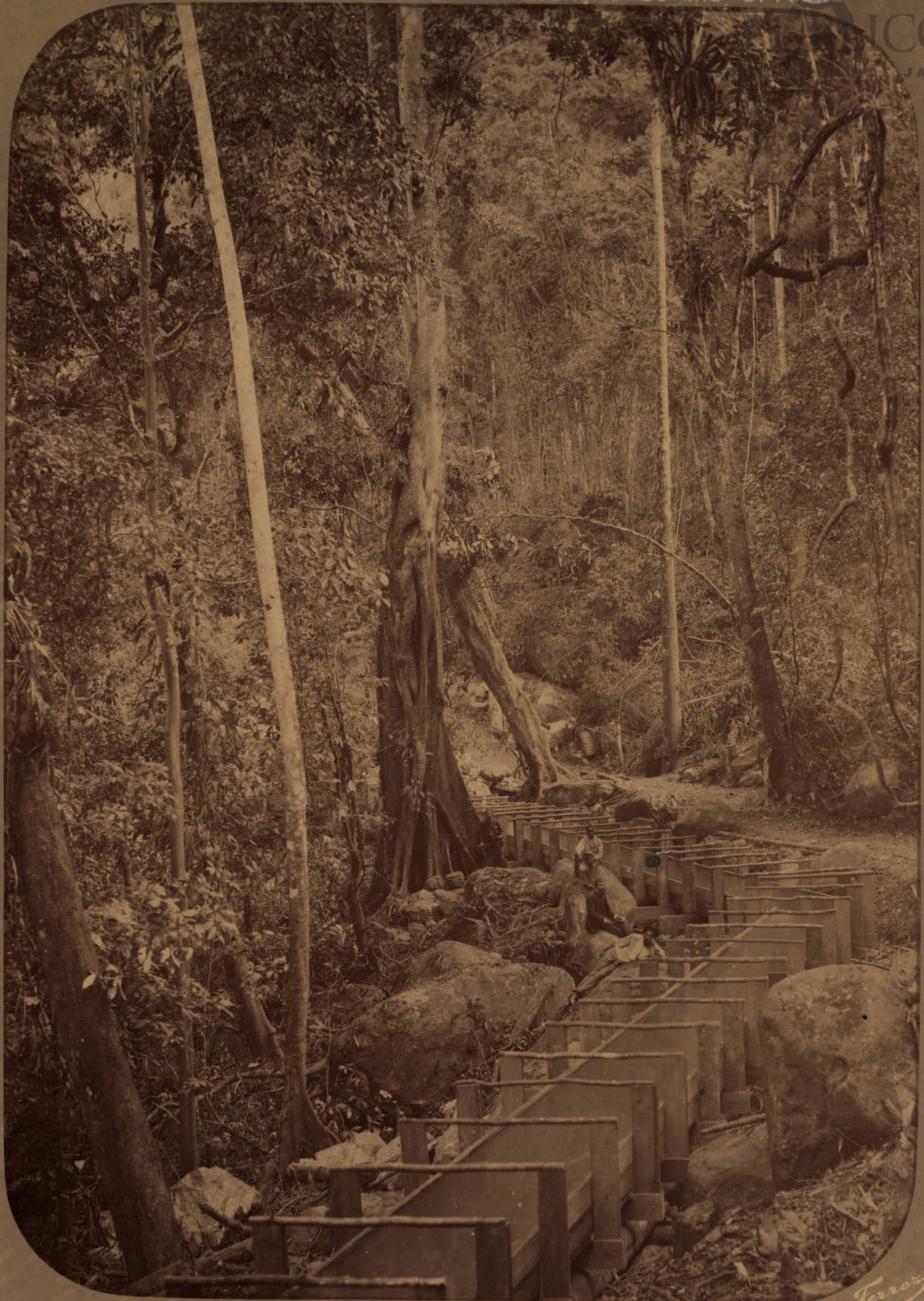
Aqueducto do Soldado .
