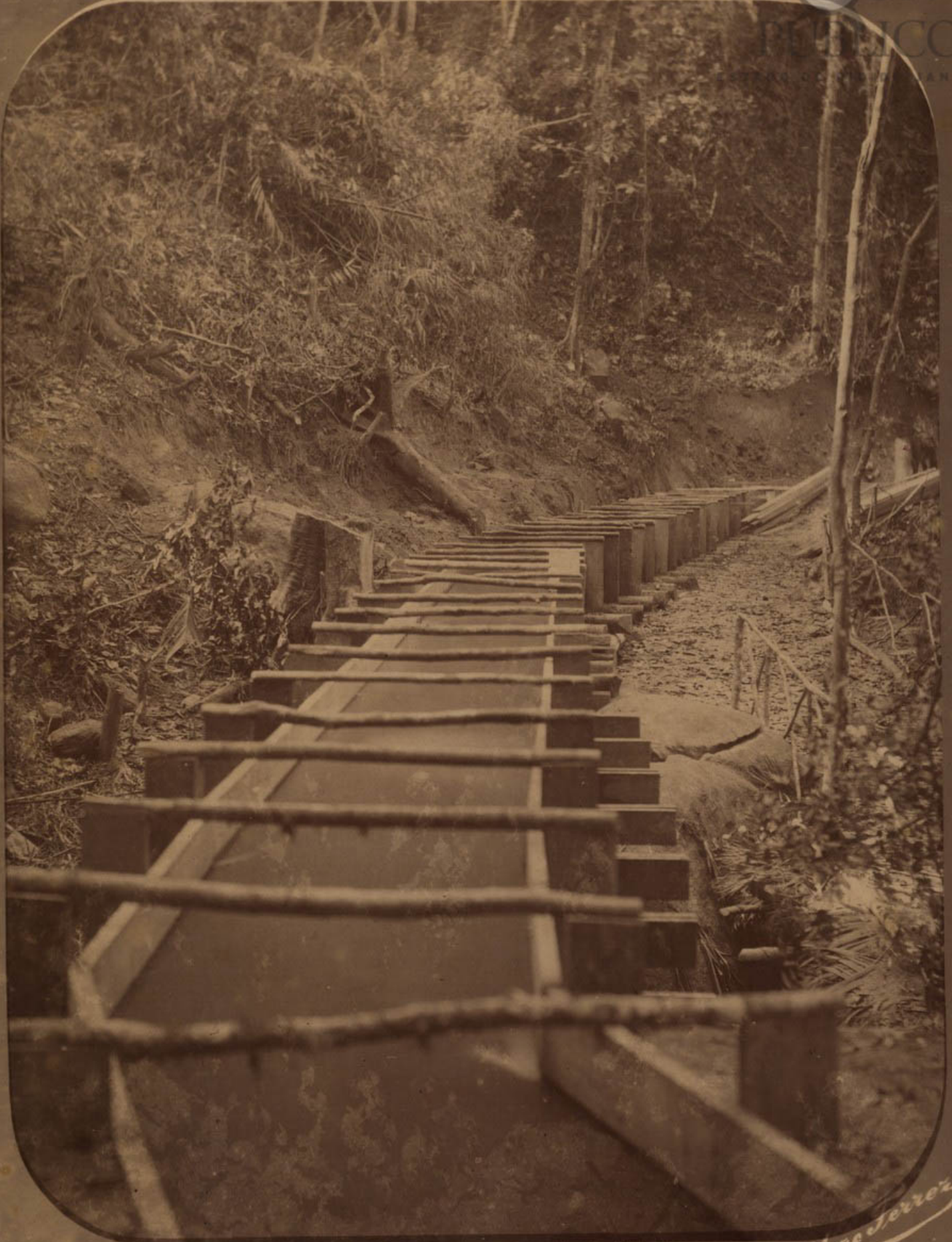
Aqueducto da grotta secca do Soldado .
