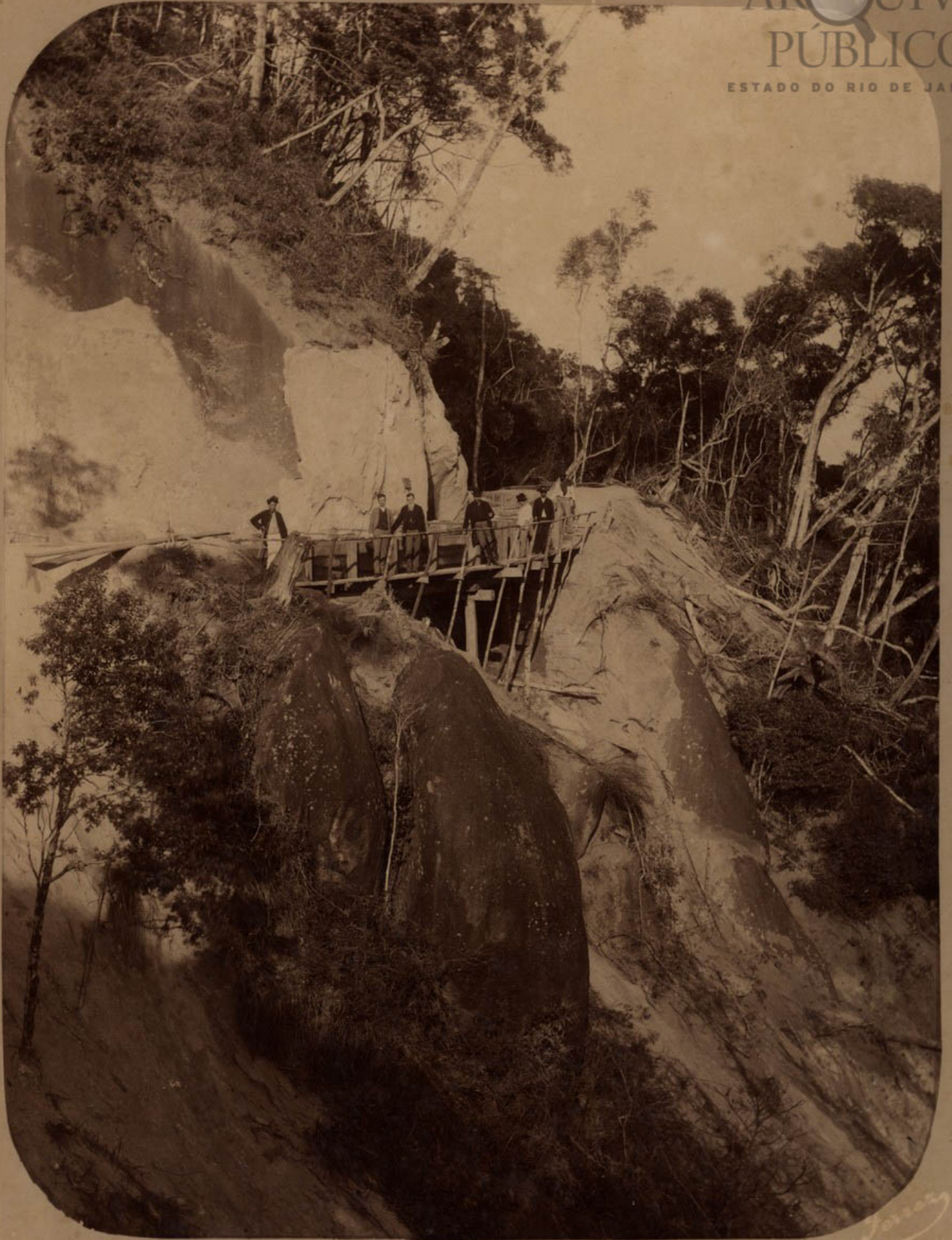
Aqueducto da Vista Alegre K. 7
