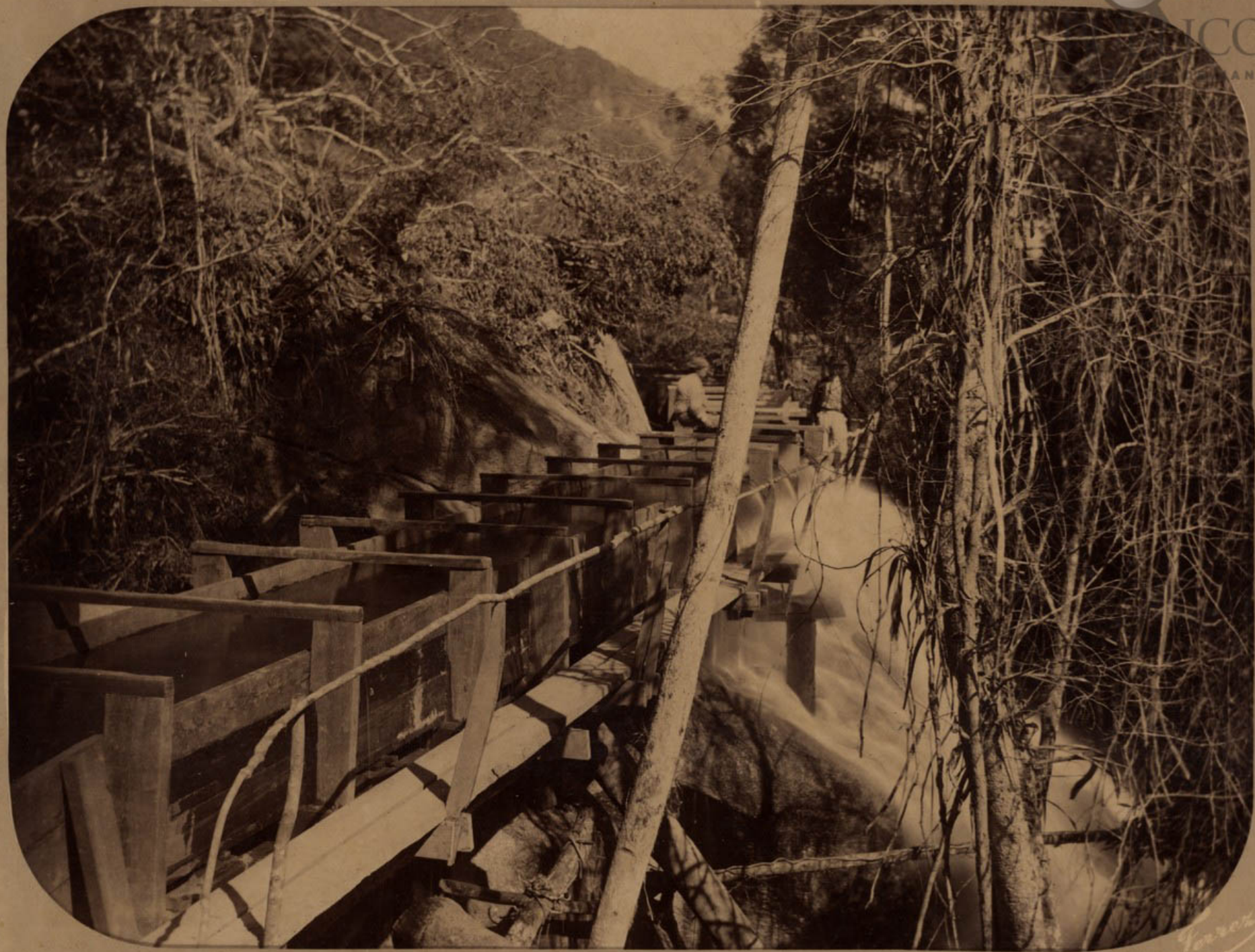
Aqueducto do Arsenal K 4
