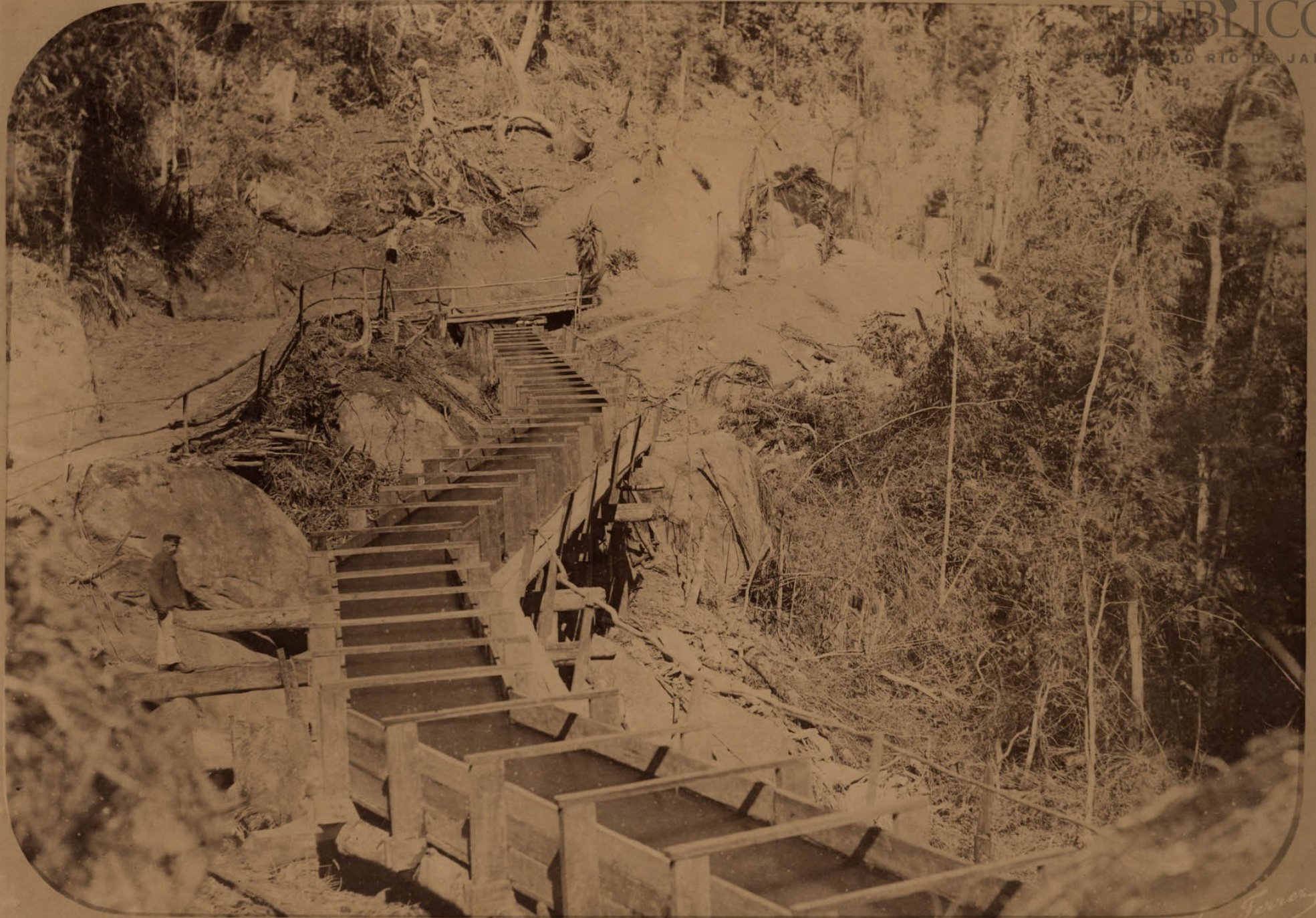
Aqueducto dos Immigrantes K. 6
