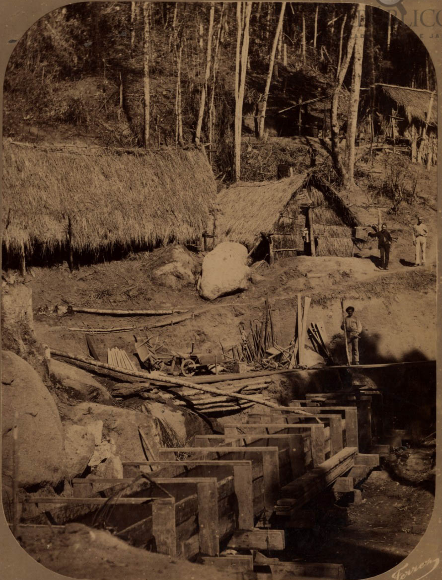
Aqueducto dos serradores K. 6.
