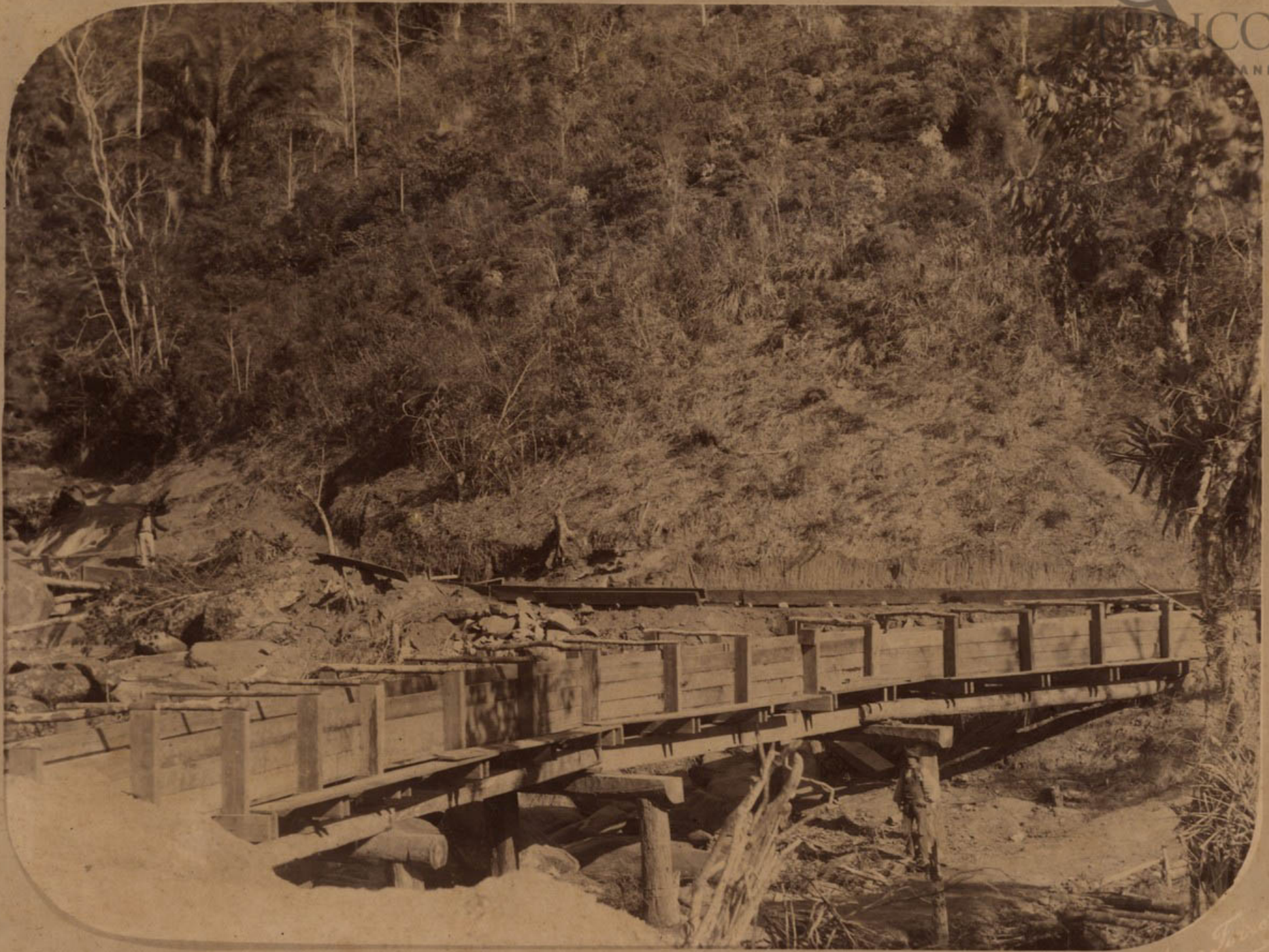
Aqueducto da Barra
