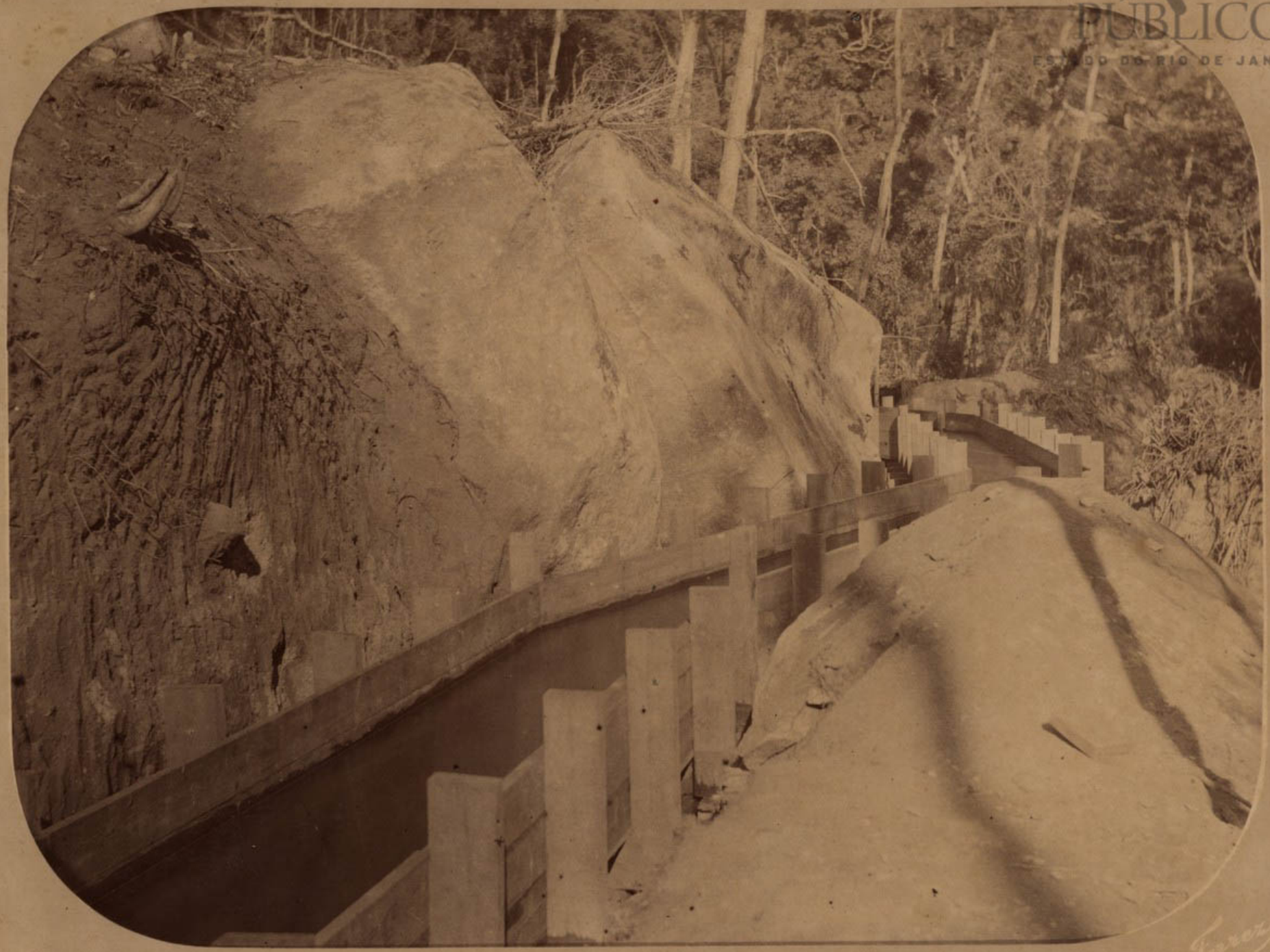
Aqueducto do Arsenal. K 4
